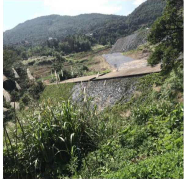
排土场拦渣坝
