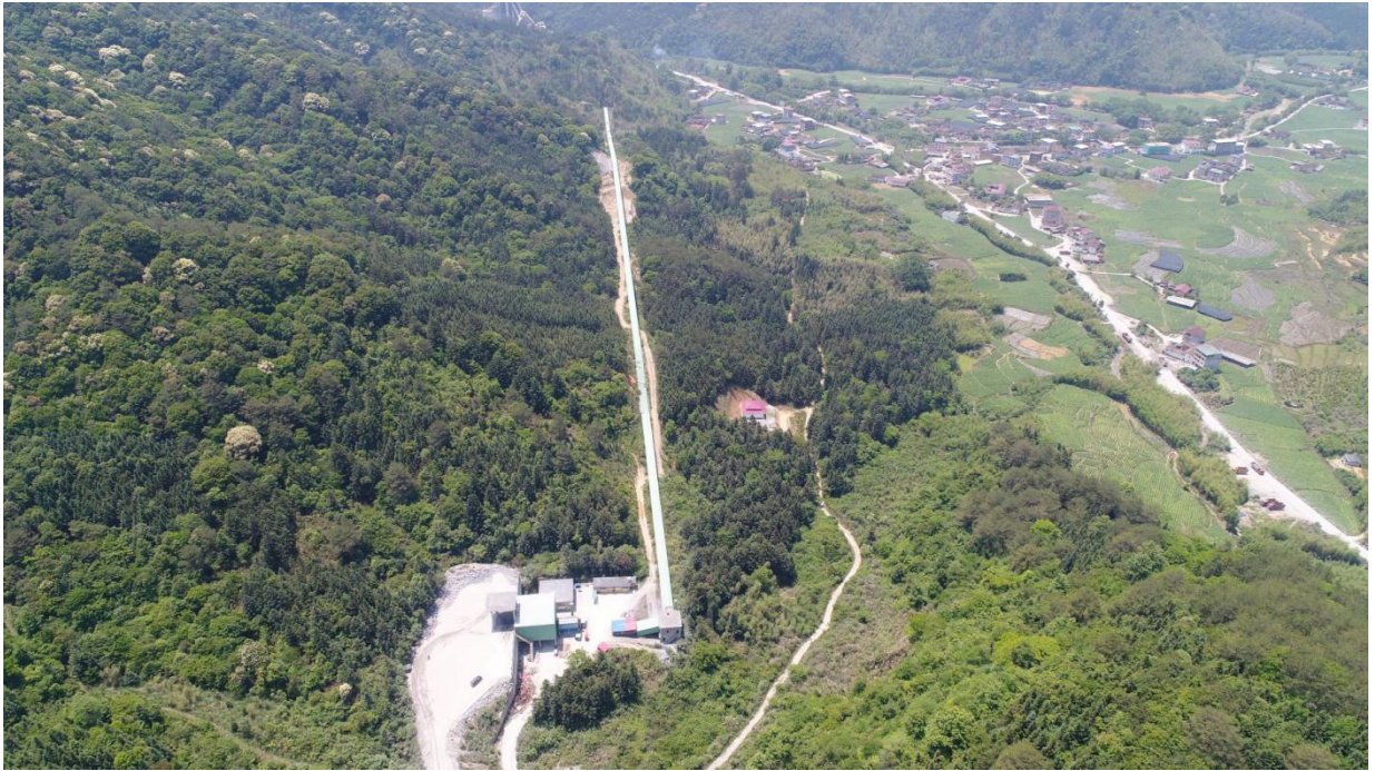
石灰石破碎场地至水泥厂皮带廊全景
