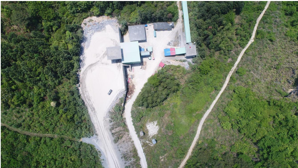
矿山石灰石破碎场地
