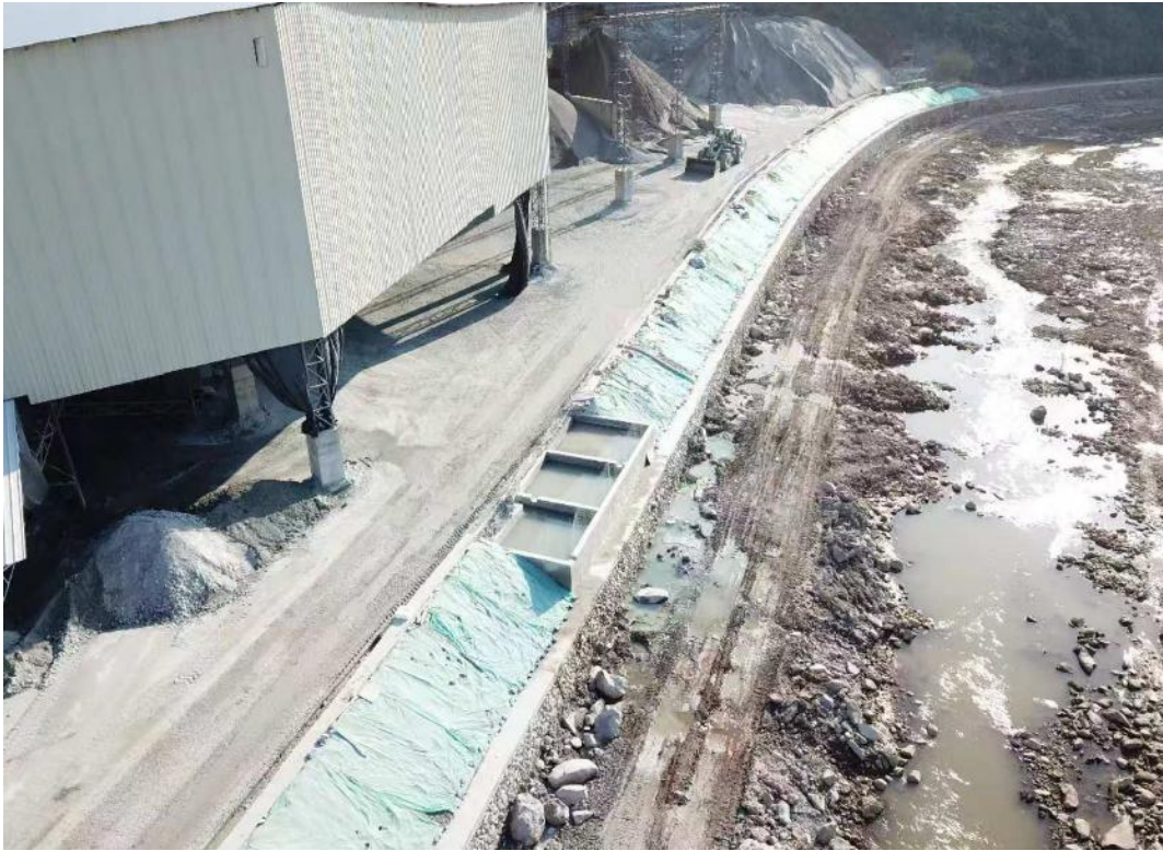
西側沉砂池及水沟
