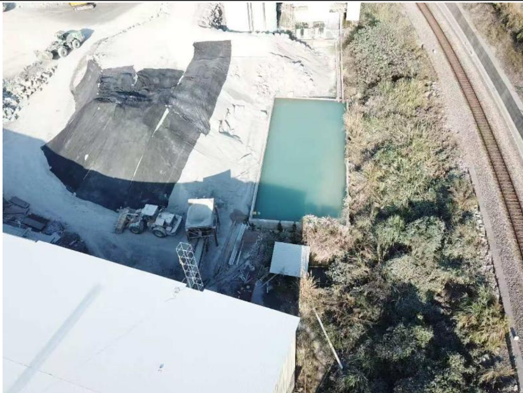
东北侧沉砂池及水沟
