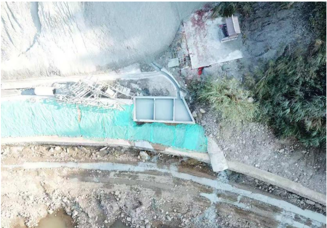
西南側沉砂池及水沟
