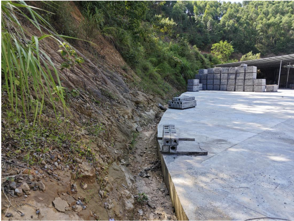
西侧截排水沟
