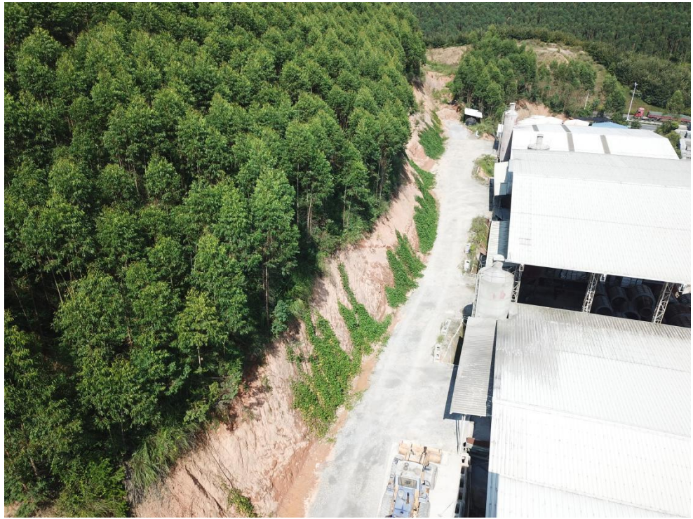
北侧边坡爬山虎
