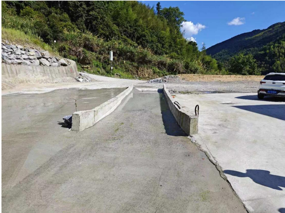
工业广场洗车台
