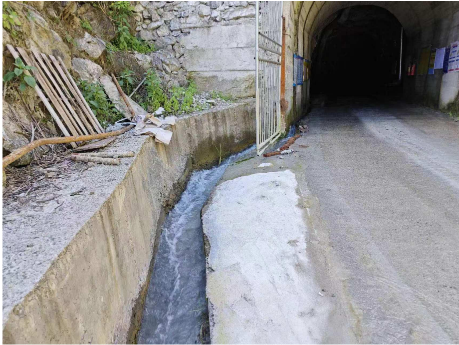
主坝口截排水沟
